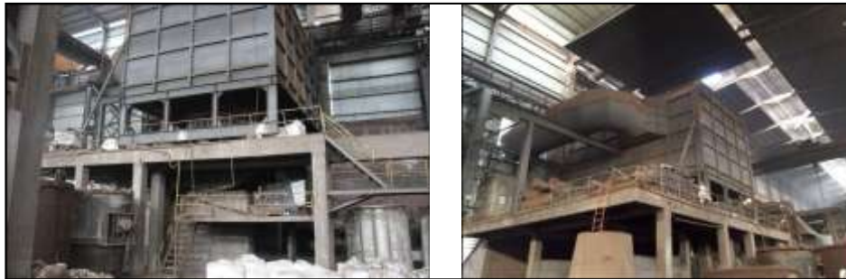
70t 电炉密闭罩
