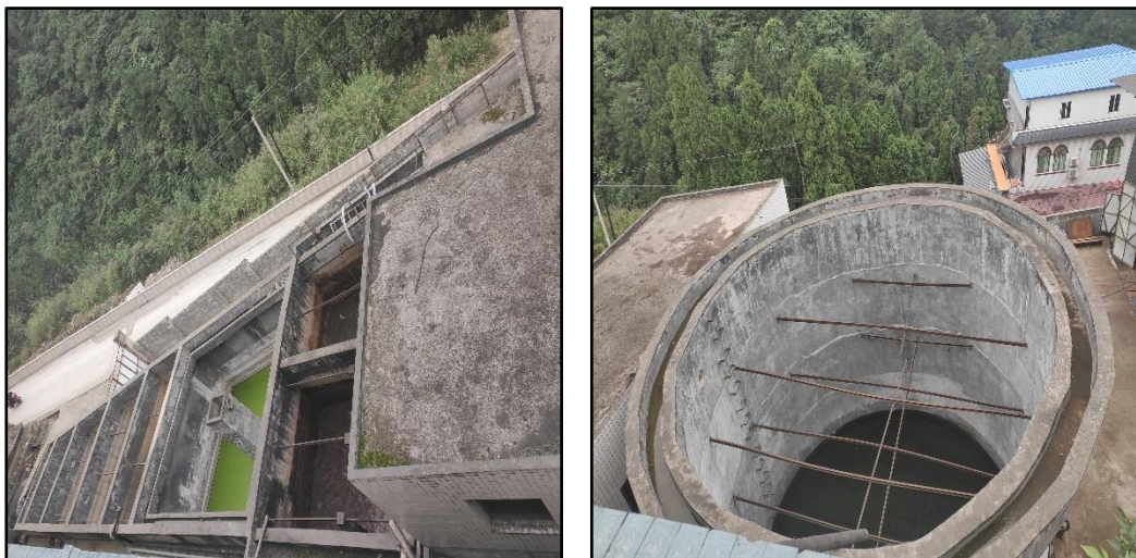
图 3.3-2 现有项目废水收集池和事故池
