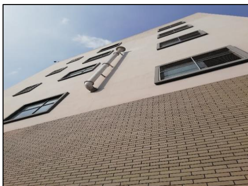
破碎粉尘排放口
