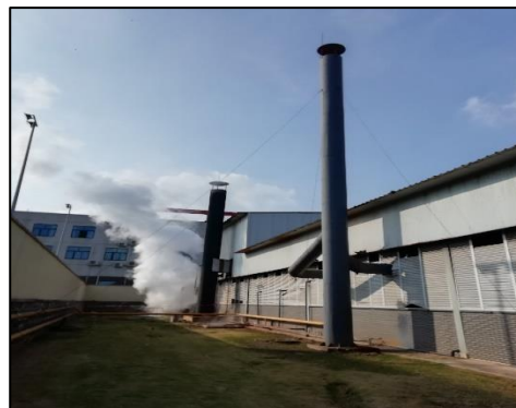
临时锅炉排放口
