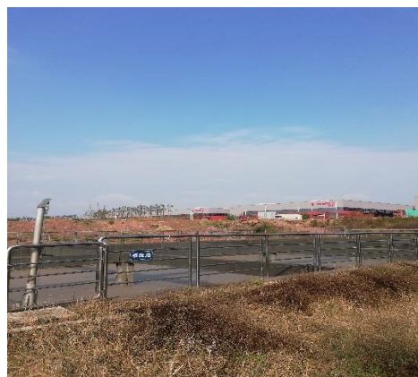
已建污水处理站事故废水池（6384.42m 3 /d）
