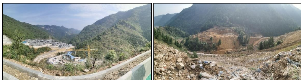
图 3.1-1 吴家沟产能区现状照片
