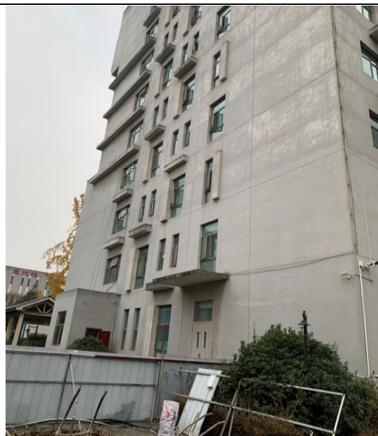
图 8-4 医用电子直线加速器机房拟建址北侧
