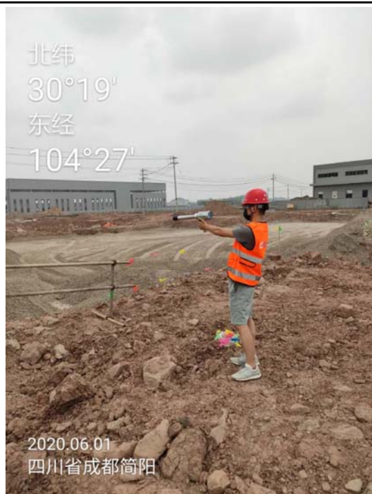
拟建扫描大厅西南侧控制室
