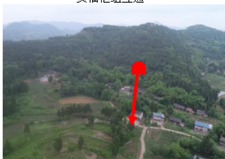
小寨隧道终点
