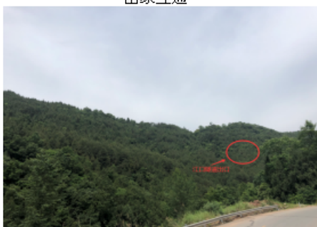
江口隧道出口
