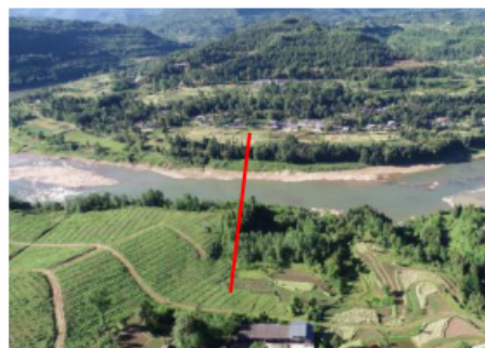
东山通江河特大桥
