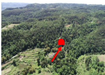
灵山隧道起点
