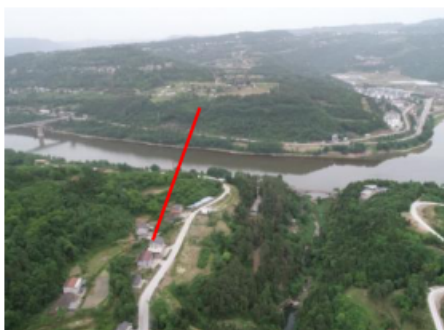
喻家溪巴河特大桥
