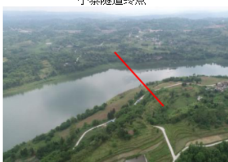
鸡公石渠江特大桥
