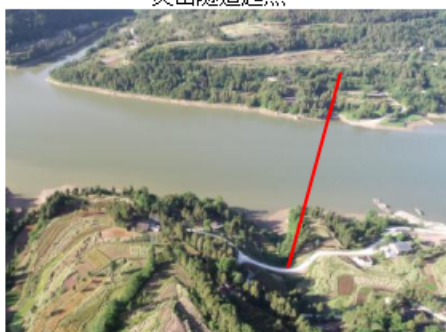
云台通江河特大桥
