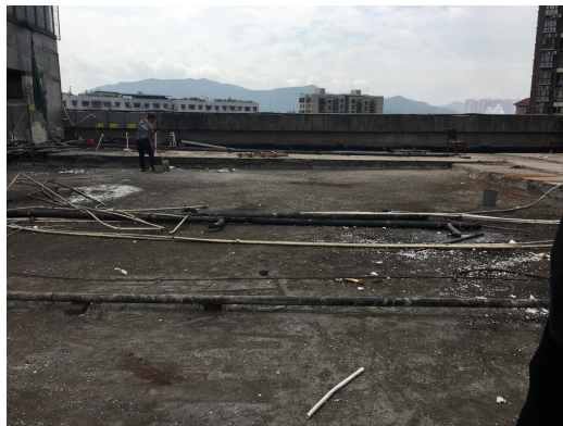
图 8-2 4F 平台现场照片
