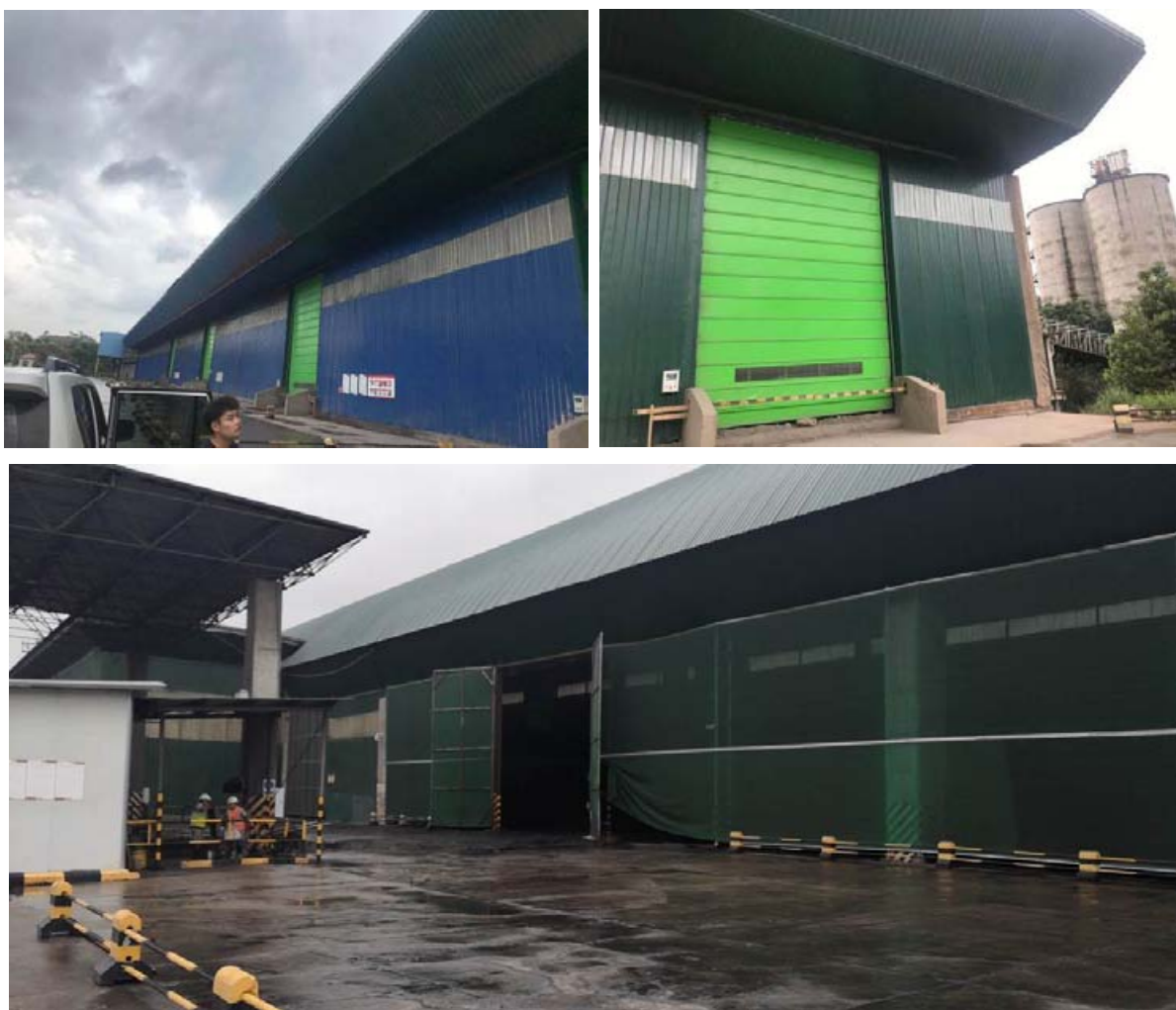
图 2.5-2 石膏和其他现状辅料堆存车间
