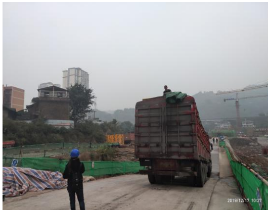
西北侧、东北侧外环境照片
