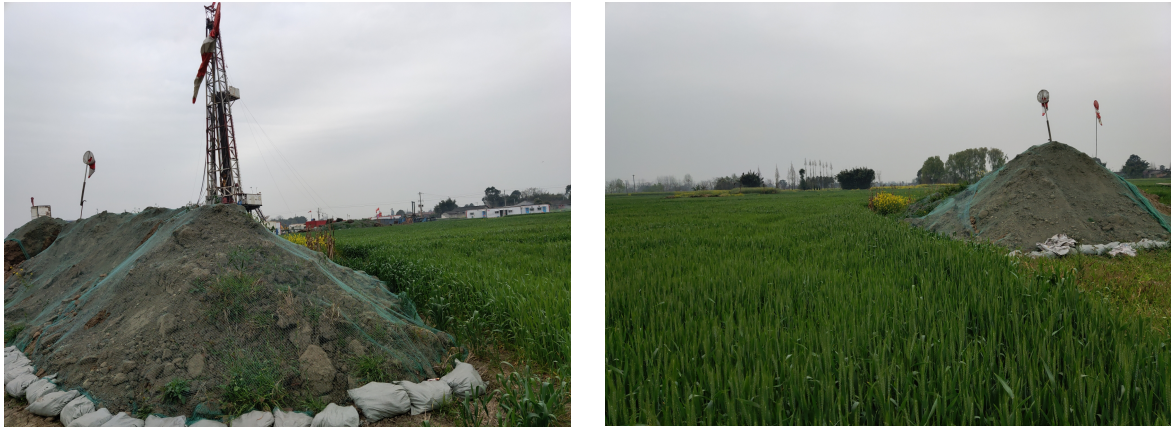
图 3-9 同类工程钻井现场临时堆土区布置现场
