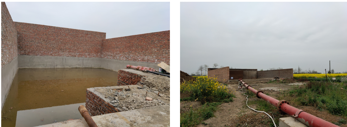
图 3-4 同类工程钻井现场放喷池布置图
