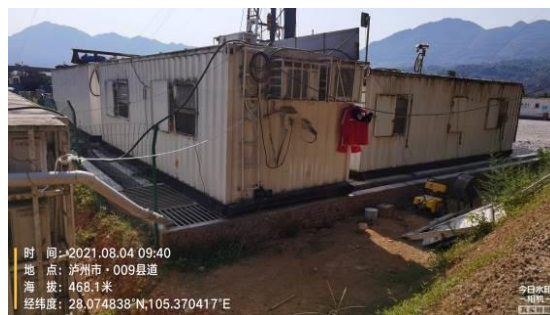
井场四周水沟
