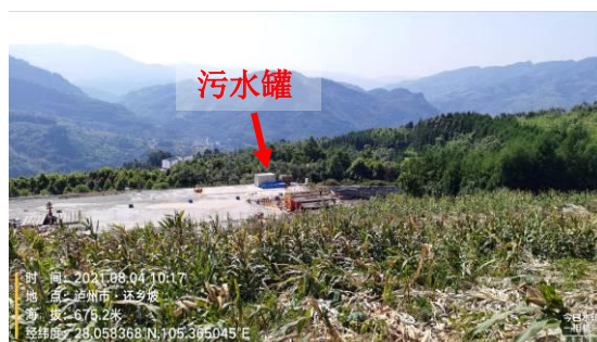
试气作业井场及污水罐
