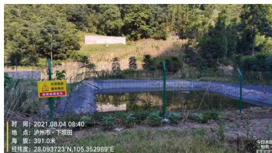
清水池及放喷坑
