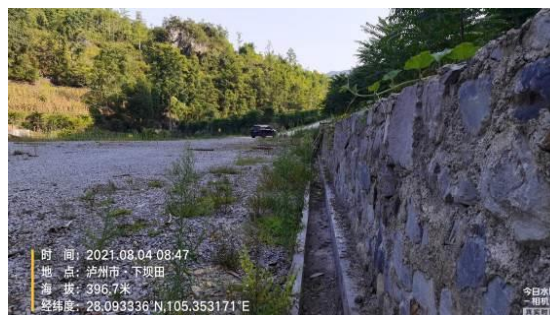
井场四周水沟
