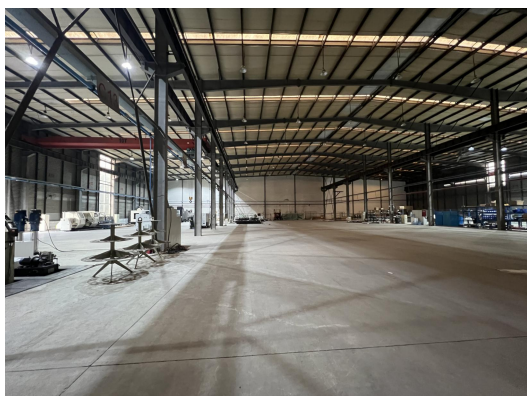
本项目铅房所在车间
