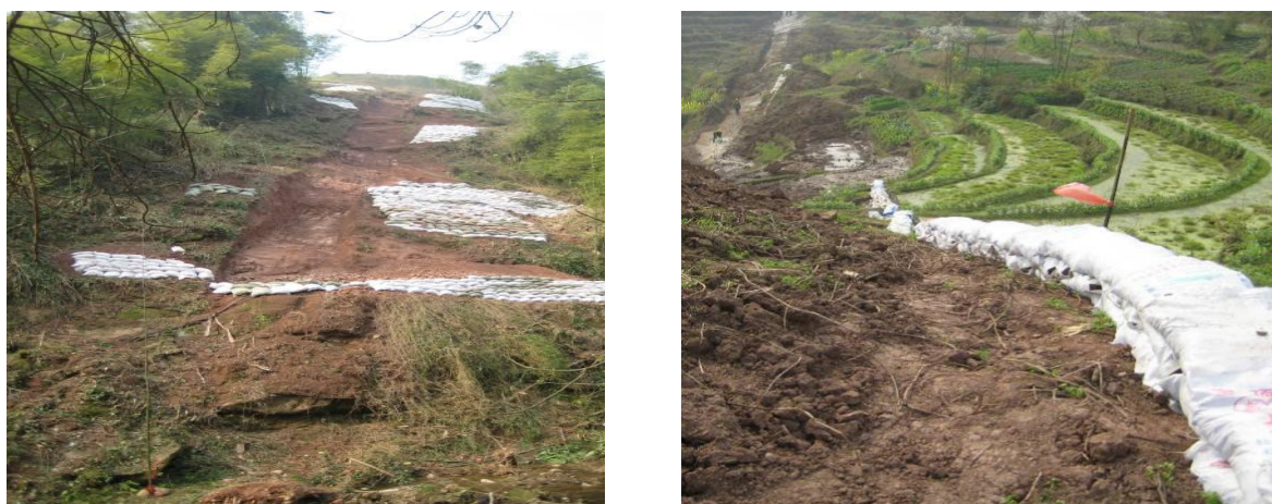
图 2.2-4 施工作业带临时水工保护措施示意图
