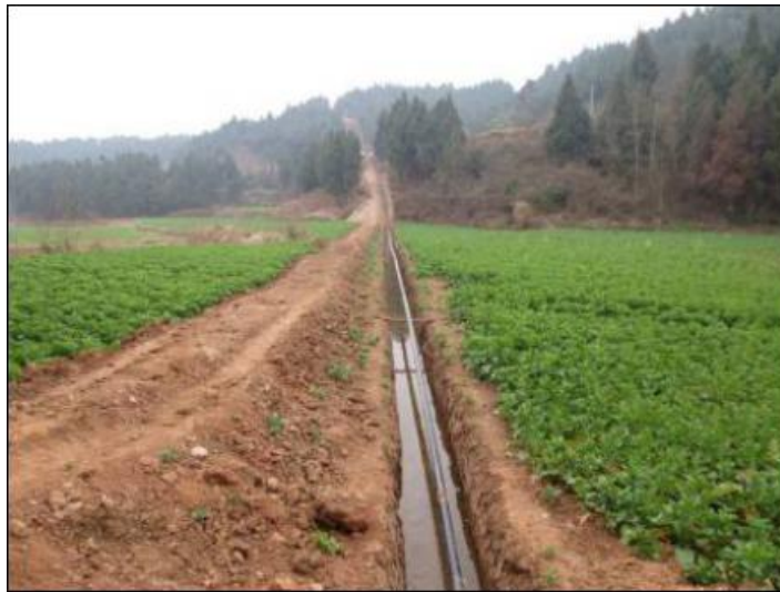
图 6.3-1 同类工程管道穿越耕地时施工作业带图
