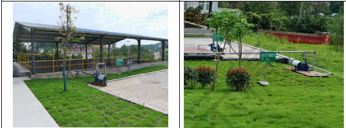
初期雨水收集池（北侧）
