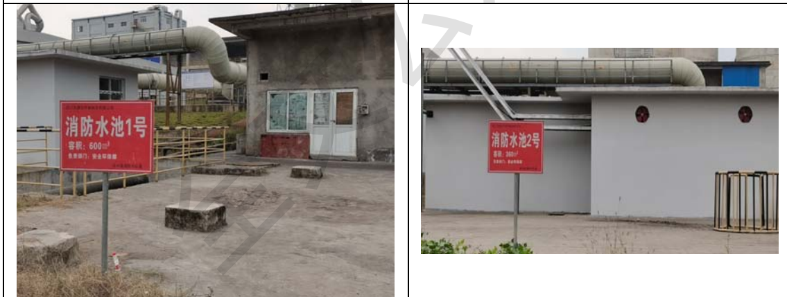
1号消防水池为星船城水泥厂，2号消防水池为天源达公司，两个消防水池串联
