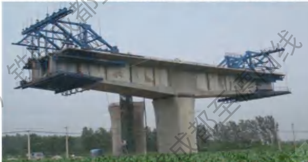
图 2.3.4-5 挂篮悬臂浇筑法
