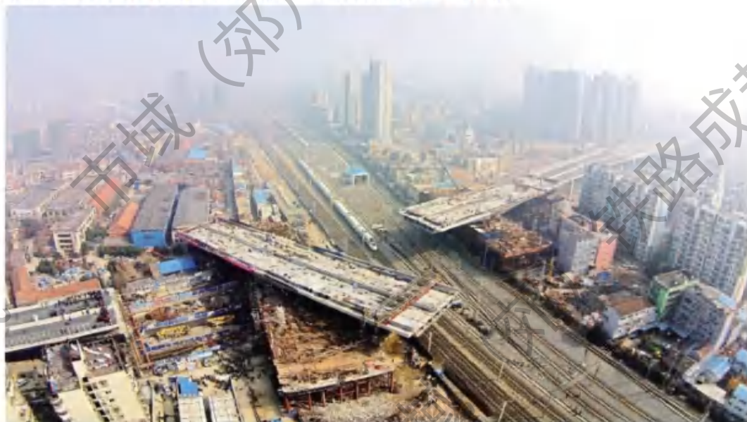
图 2.3.4-6 转体施工法
