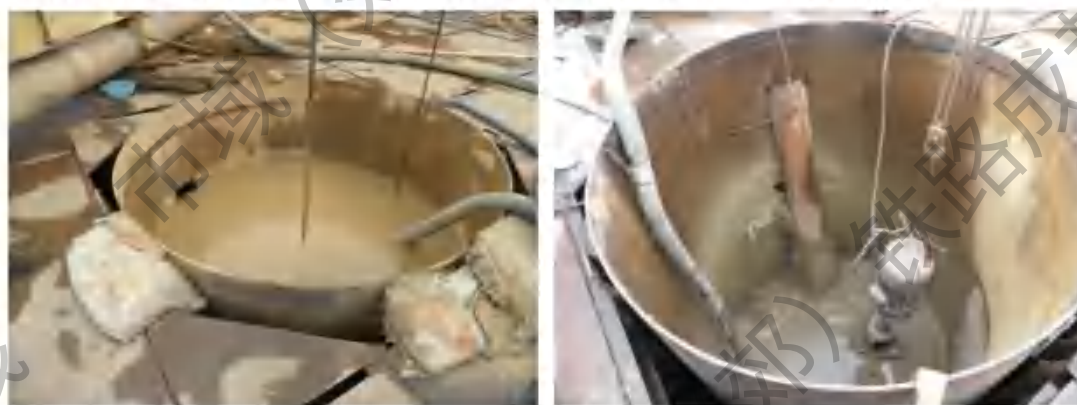
图 5.4.2-2 桥梁围堰施工
