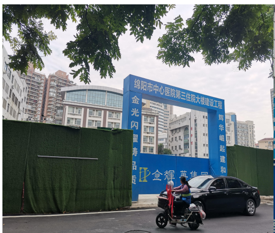
第三住院大楼（在建）
