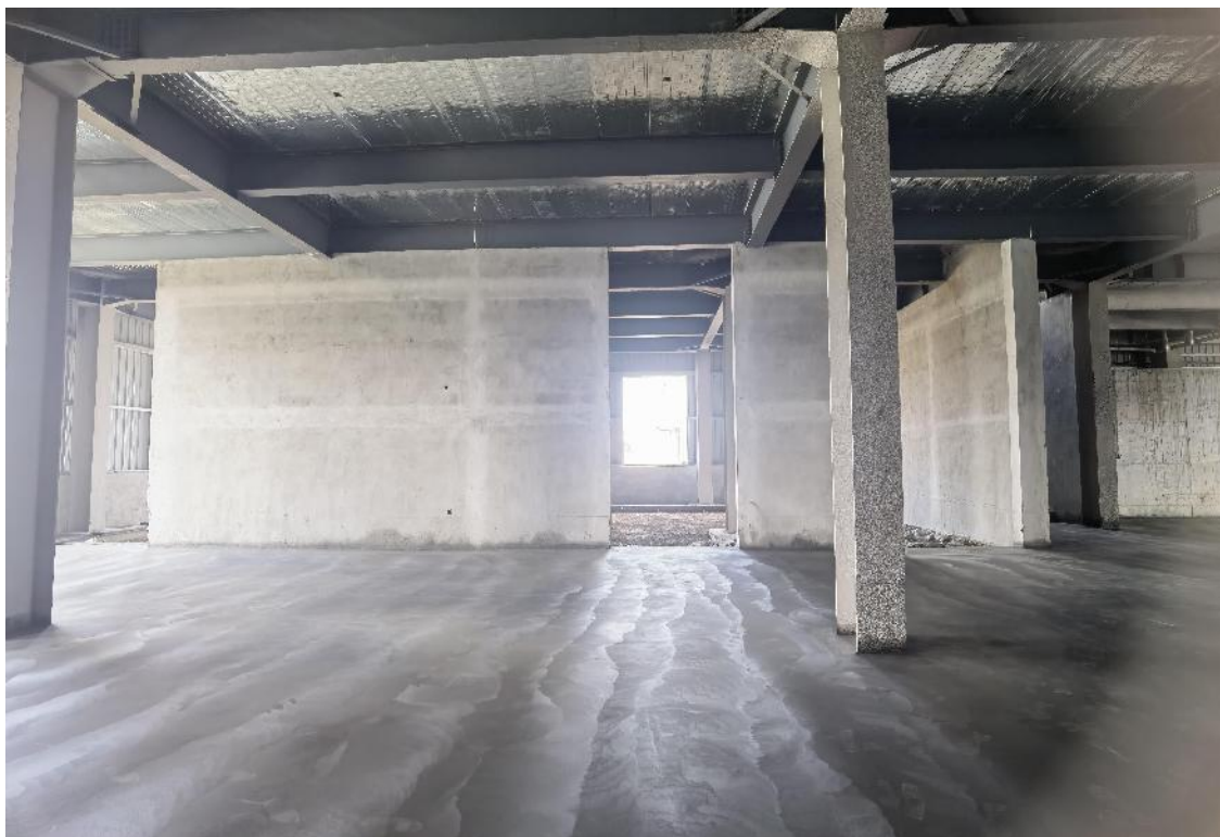
图 8-1 探伤室拟建地
