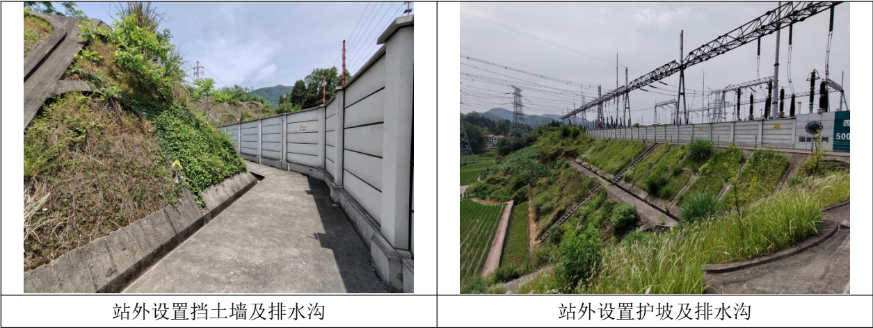
图 3.1-6 玛瑙500kV 变电站前期工程已采取的主要环保设施、措施
