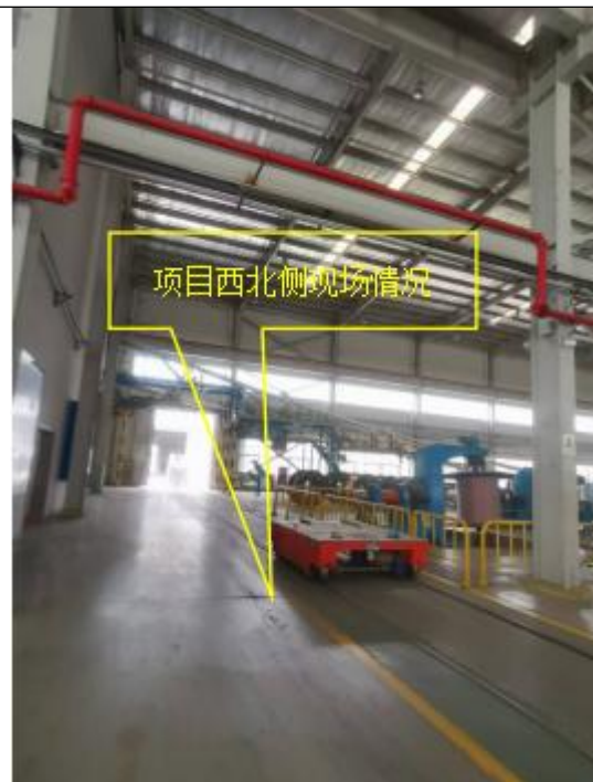
图 8-3 本项目西北侧现场情况
