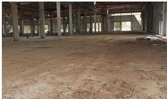
探伤室拟建场址东侧
