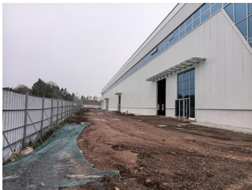
探伤室拟建场址南侧
