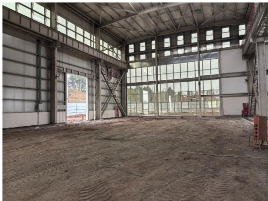
本项目探伤室拟建场址
