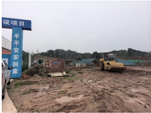
探伤室拟建场址西侧厂区道路和7#加工车间
