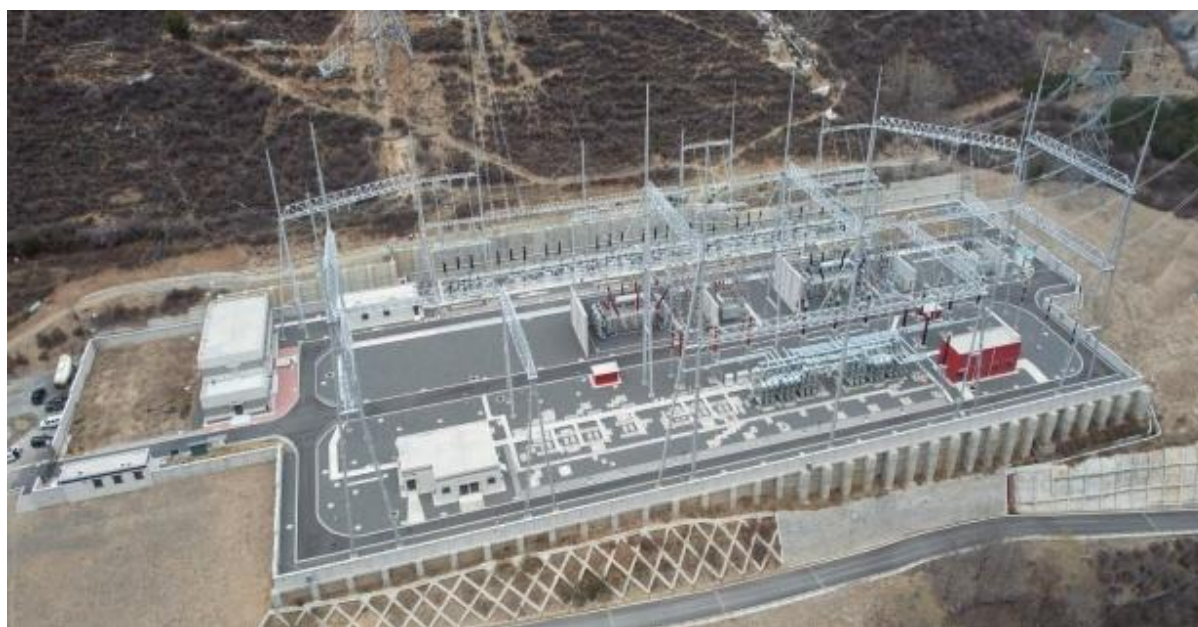
图 3-2 马尔康 500kV 变电站站址现状
