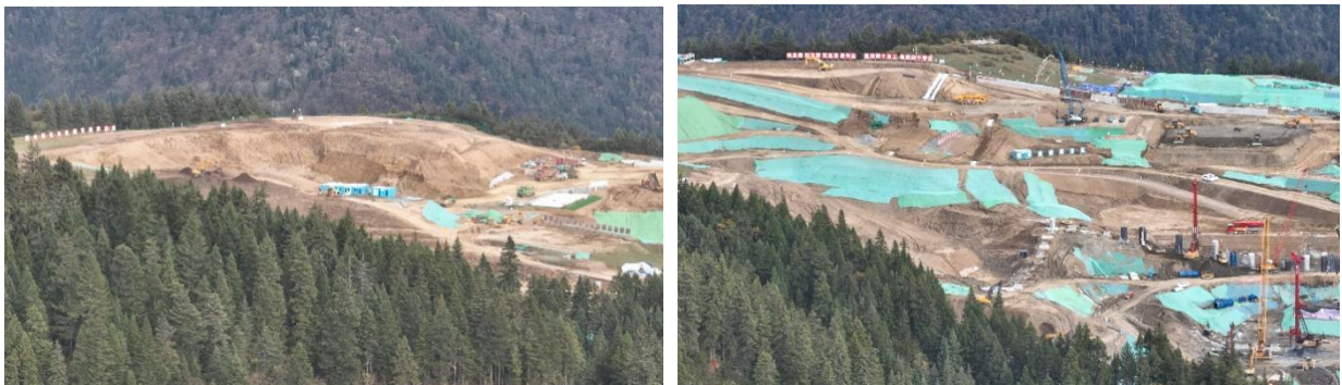
图 4-1 阿坝 1000kV 变电站站址现状及周边地貌
