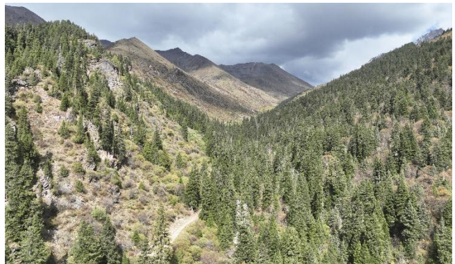
输电线路沿线（ \pi 接线路）
