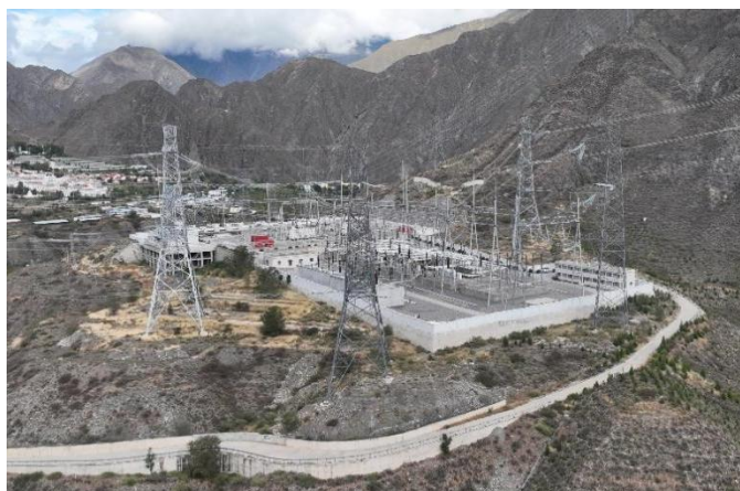
图 3-4 色尔古 500kV 变电站站址现状
