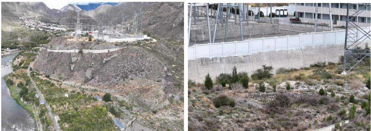
图 4-3 色尔古 500kV 变电站站址现状及周边地貌
