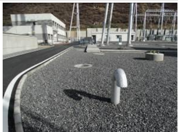
主变事故油池
