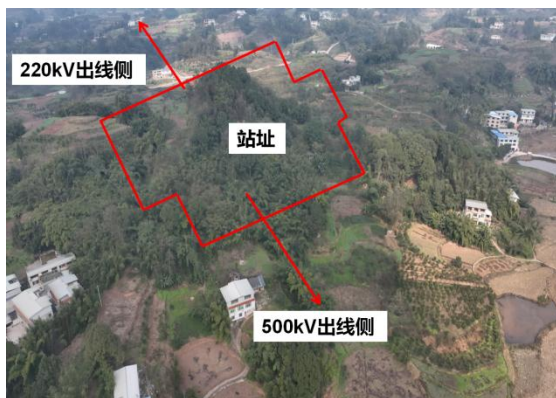
图 4-1 宜宾南变电站站址现状 1
