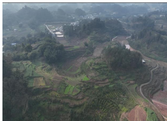
图 4-2 宜宾南变电站站址现状 2
