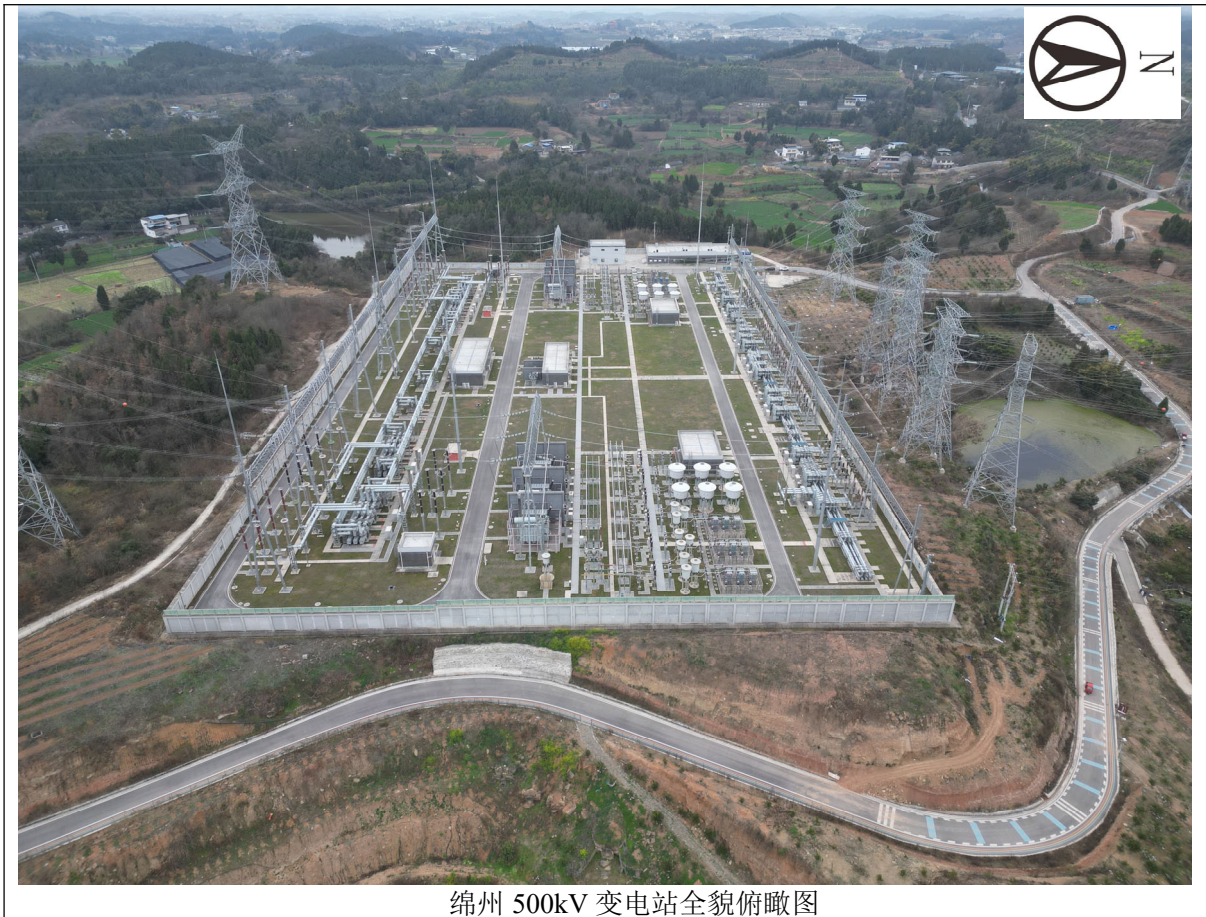
图 4-1 绵州 500kV 变电站环境现状
