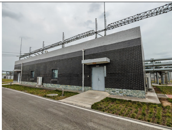
500kV 及主变继电器室
