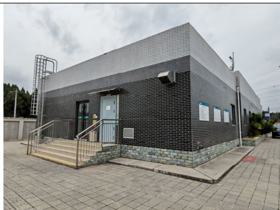
站内主控综合楼
