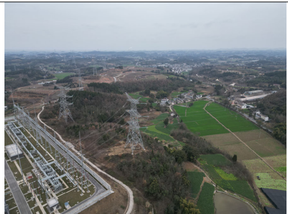
绵州 500kV 变电站南侧围墙外环境
