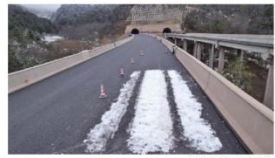
乐西高速公路施工现场，车辆正在行驶。
