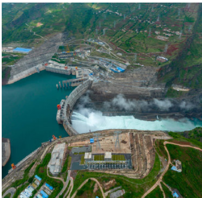
白鹤滩水电站
