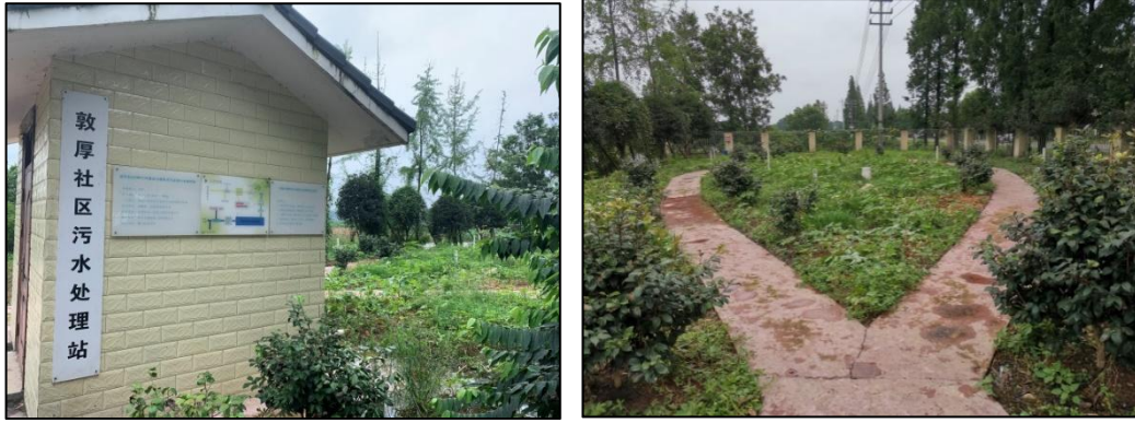
图 4-16 “预处理+人工湿地”工艺现场图（左：污水处理站；右：土地处理）
