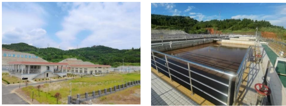
图 2-10 南充市文峰污水处理厂二期工程项目
