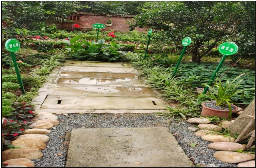
图 4-14 “预处理+人工湿地”工艺全景图
