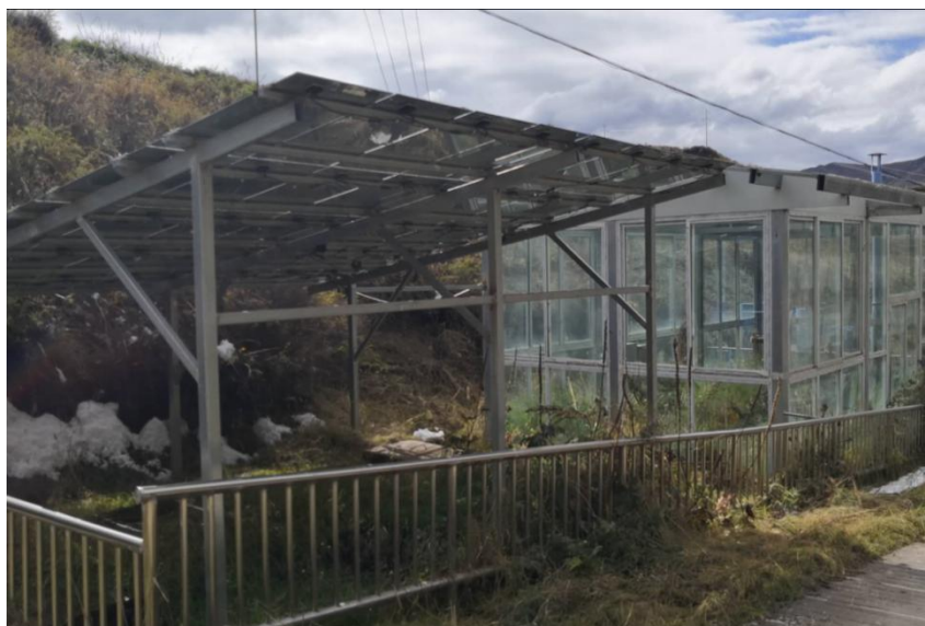
图 4-29 “厌氧+生物接触氧化工艺”全景图
