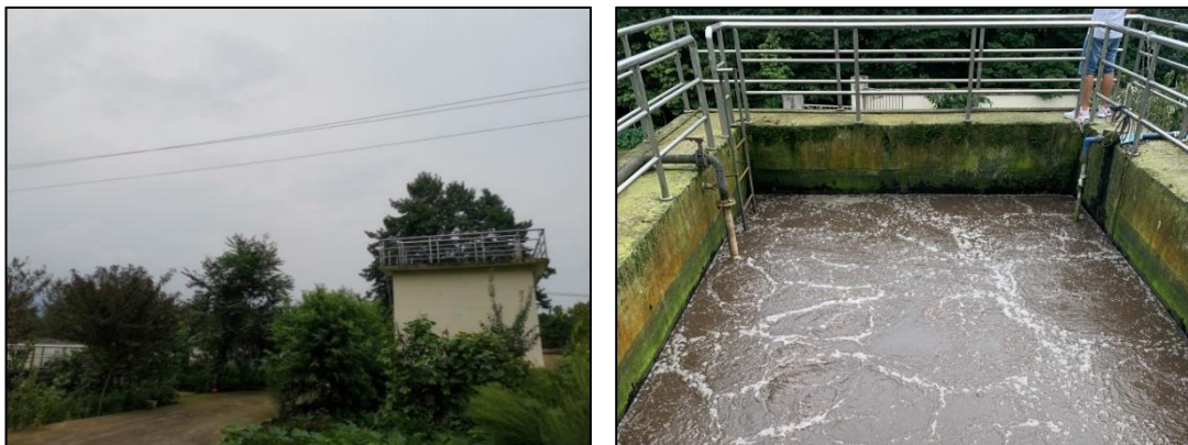
图 4-18 “预处理+SBR”工艺（左：工艺全景图；右：SBR 反应器）
