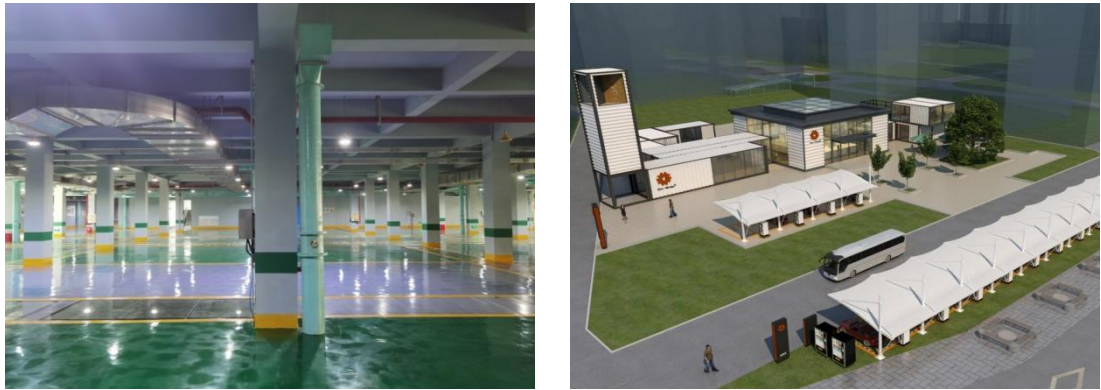
图 2-6 广安市污水处理厂项目
