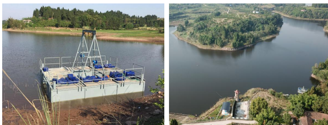
图 6-6 四合水库水源地水质提升项目
