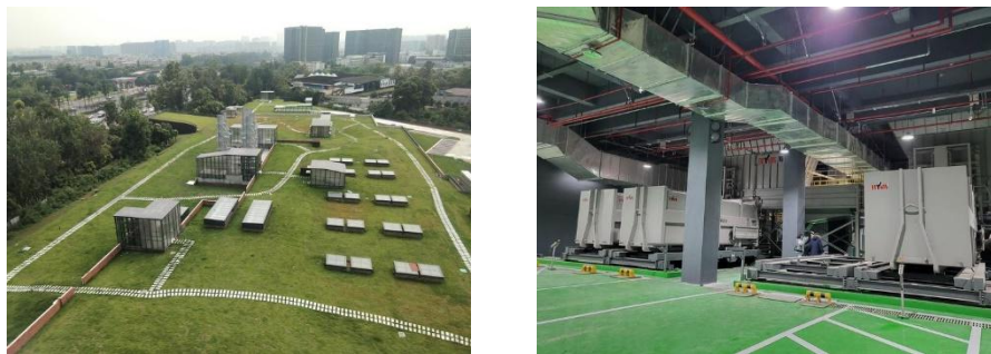
图 4-7 成都市武侯区地下垃圾压缩转运站地面（左）、垃圾压缩转运中心内部（右）
