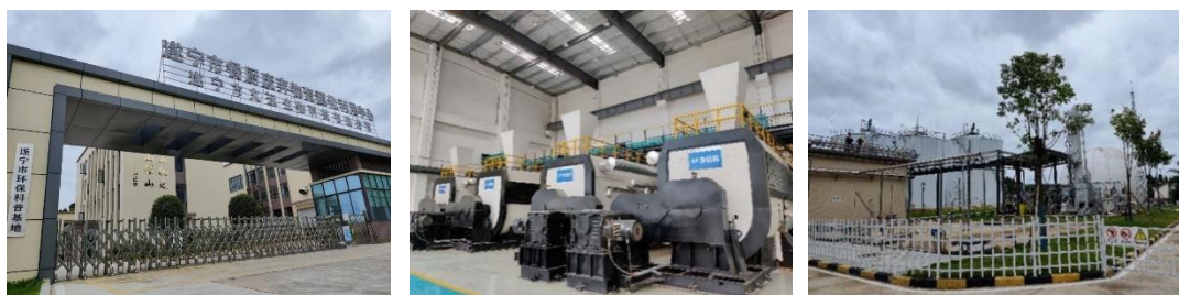
图 4-14 遂宁市餐厨垃圾及废弃油脂资源化综合利用项目（左）、生化处理系统（中）、厌氧处理系统（右）
