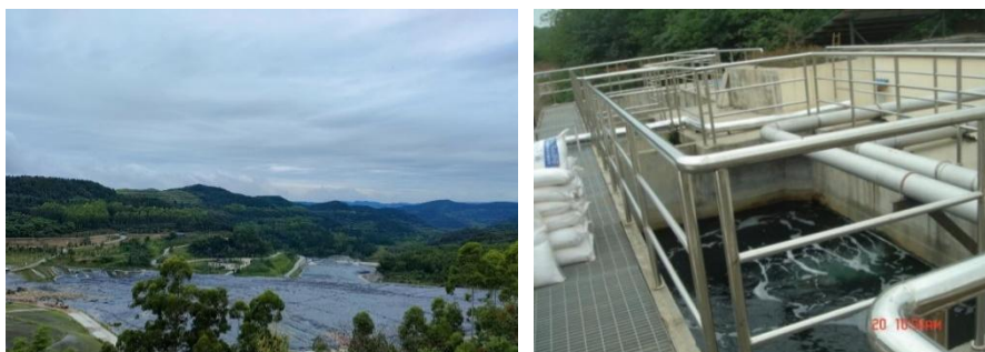
图 4-12 成都市固体废弃物卫生处置场（三期）填埋区（左）及渗滤液处理工程（右）
