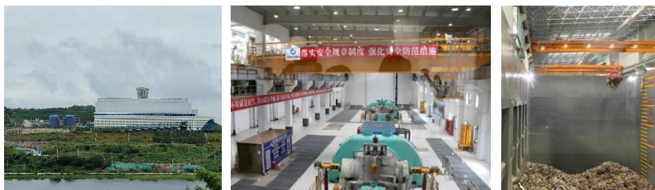
图 4-9 某环保发电厂二期外景（左）、汽机车间（中）与垃圾仓（右）
