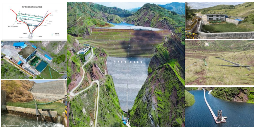
图2-10 凉山某绿房箐沟尾矿库雨污分流
