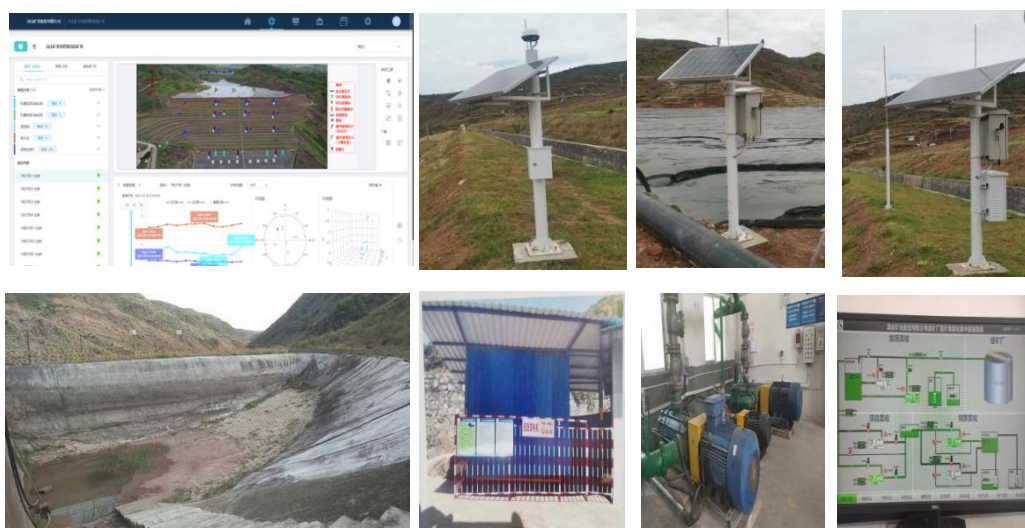
图2-12 凉山某房箐沟尾矿库在线监测及应急系统
