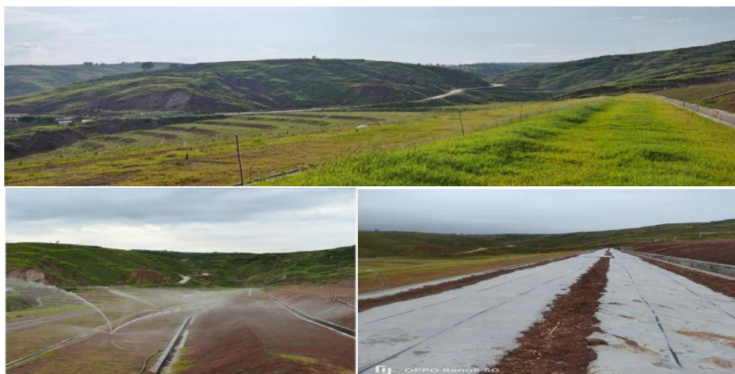
图2-11 凉山某房箐沟尾矿库薄膜覆绿法
