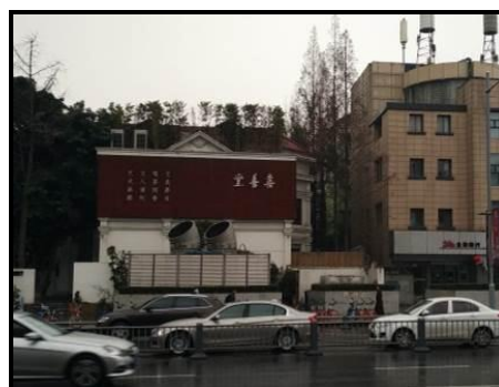
2 号线红色村站冷却塔导声筒措施
