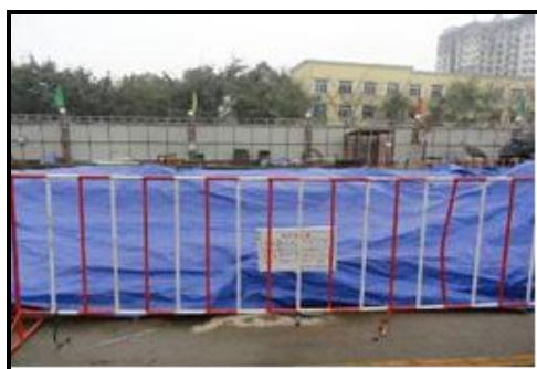
2 号线施工材料堆放
