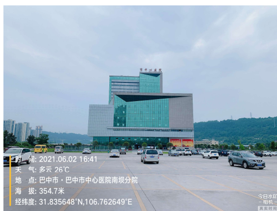
图 8-2 核医学科楼拟建址南侧
