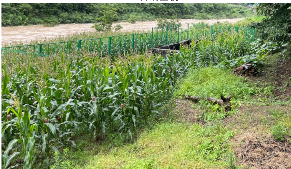
(2) 填埋池、废水池现状
