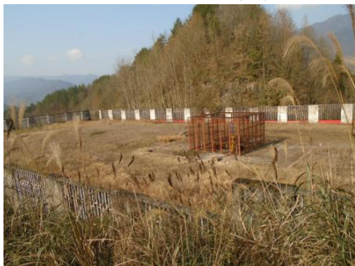
(1)坡 2 井井场全貌
