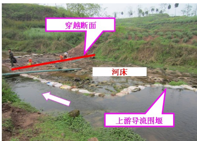
图 4.1-9 围堰开挖管沟法施工现场图
