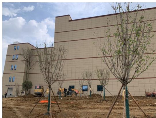
本项目影像中心所在动物楼
