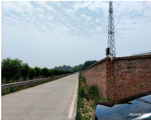
项目厂区东侧
