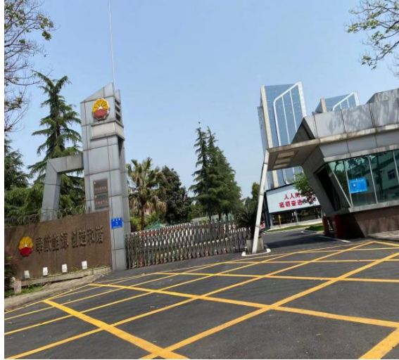
西北侧邛崃配气站
