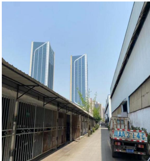
东北侧金工车间
