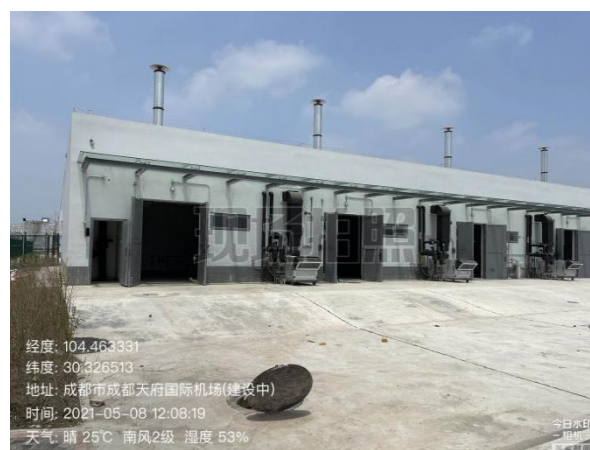
图8-8 双机位宽体机库外西北侧危废暂存间
