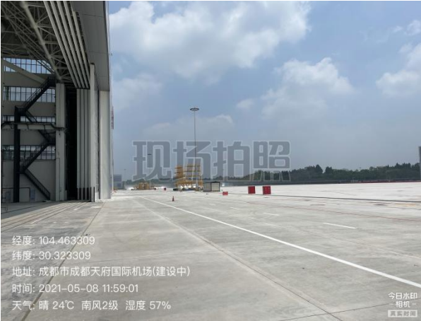
图8-2 双机位宽体机库东侧机坪
