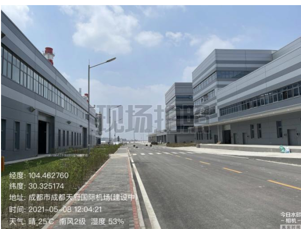
图8-6 双机位宽体机库西侧室外道路
