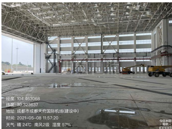
图8-3 双机位宽体机南侧喷漆机库图
