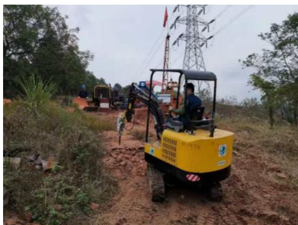
线路工程开挖运输多功能车示意图
