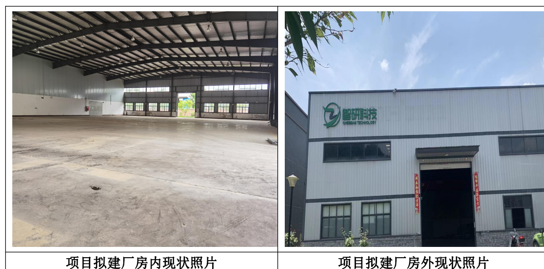
图8-1 本项目拟建场所现状图
