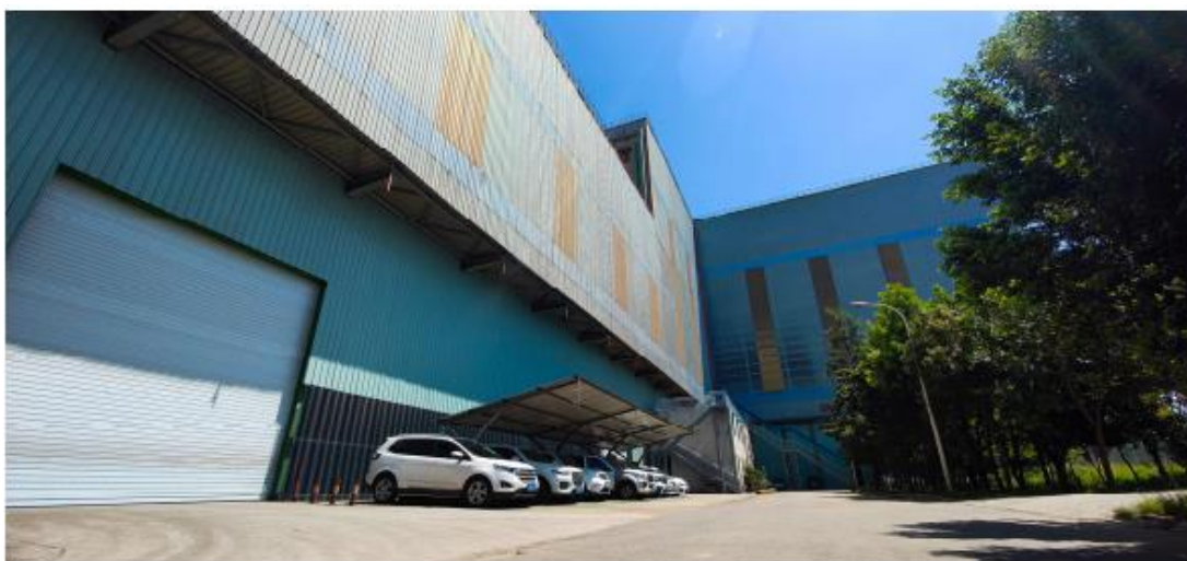
图 2.7.1-3 炼钢厂厂房全封闭
