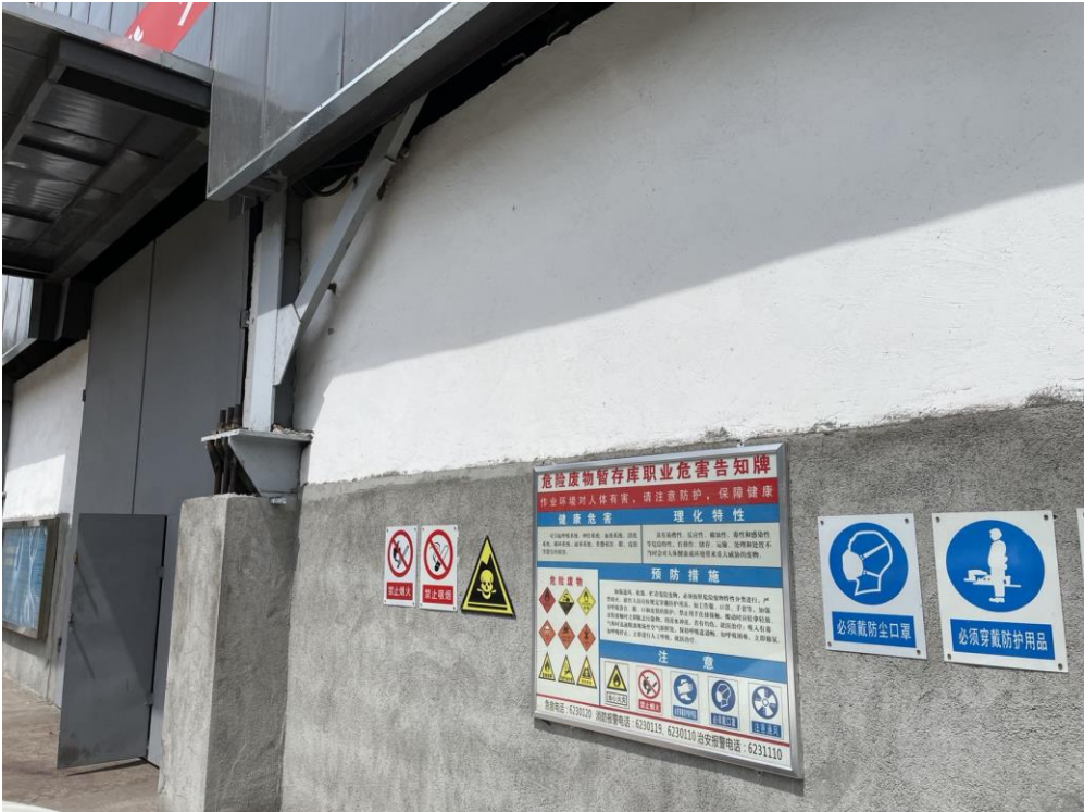
图 2.6-7 厂区危废暂存间现状图
