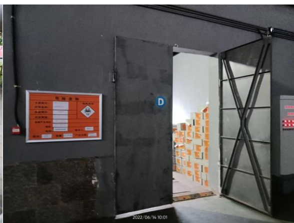
废铅酸蓄电池暂存点
