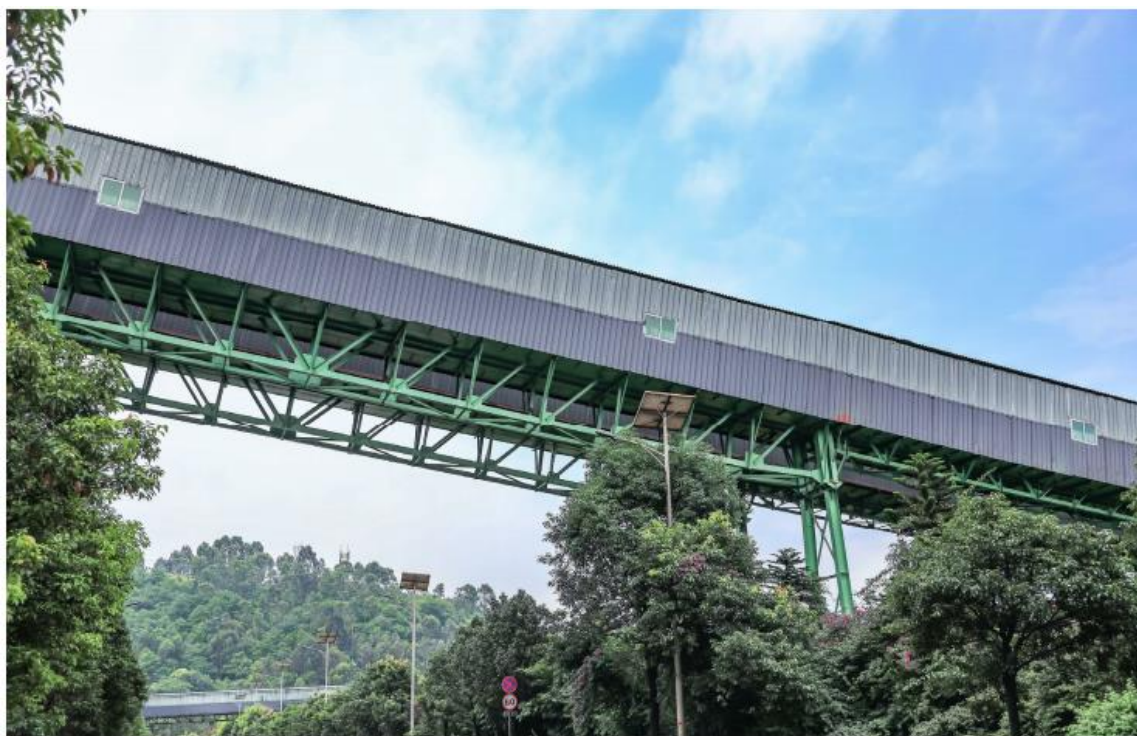
图 2.7.1-1 物料输送皮带通廊全封闭
