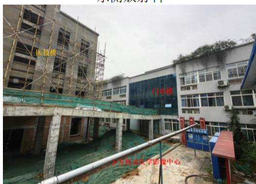
北侧门诊楼、西侧医技楼
