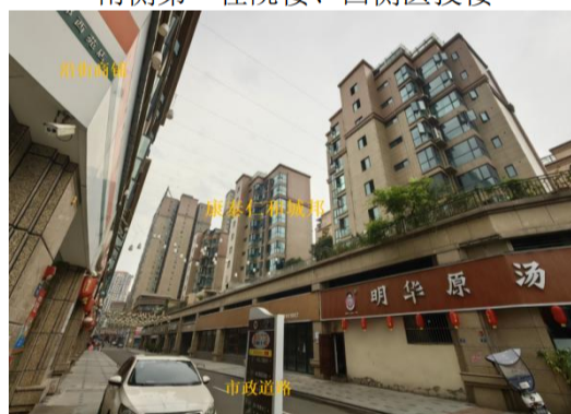
东侧 沿街商铺
