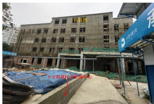
拟建医学影像中心现状
