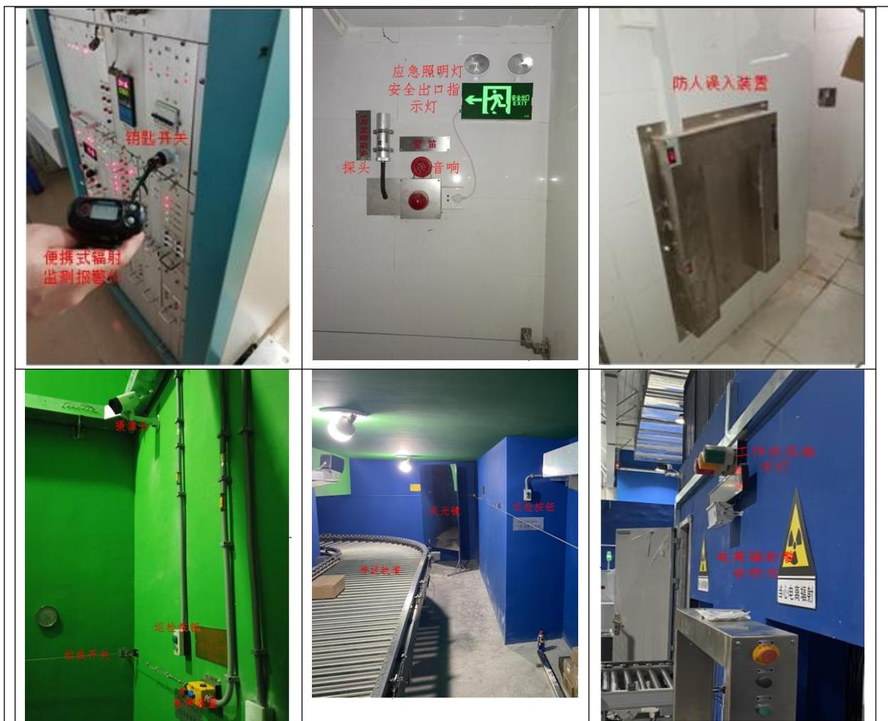
图 10-4 同类型加速器的安全装置和防护措施现场照片
