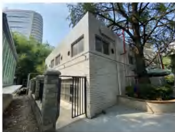
本项目西南侧锅炉房、燃气站
