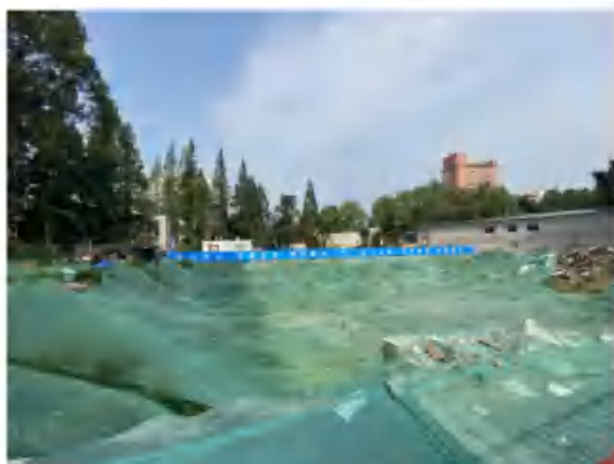
本项目所在综合科研大楼拟建地现状
