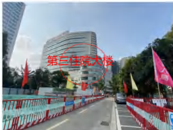
本项目南侧第三住院大楼
