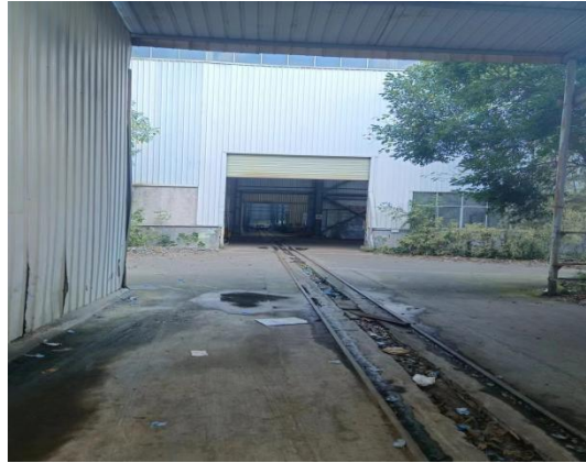
探伤室东侧德阳立达机电设备有限公司
