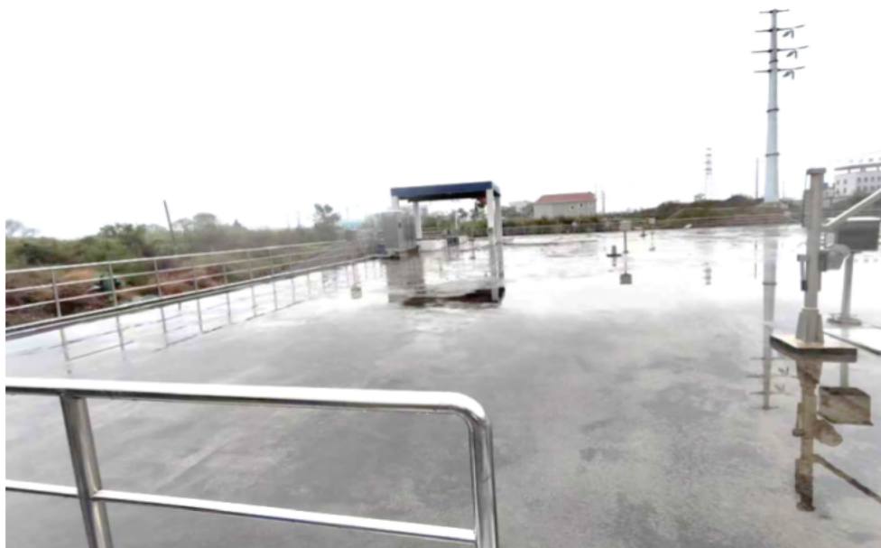
图 7.5-3 园区容积约 10000m 3 的事故应急池（已有）
