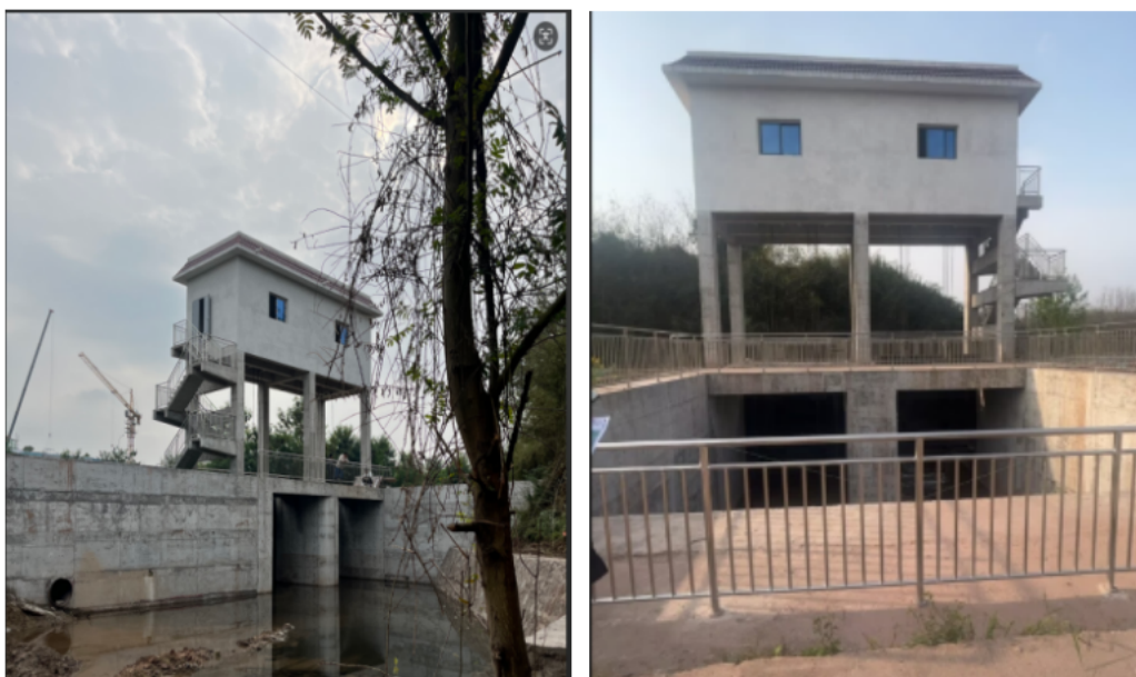
图 7.5-2 园区 2#拦污闸和 3#拦污闸 (已有)
