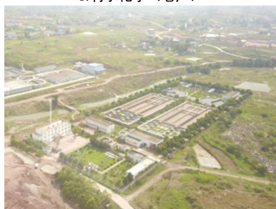
d. 园区污水处理厂
