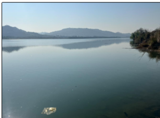
青居航电枢纽库区
