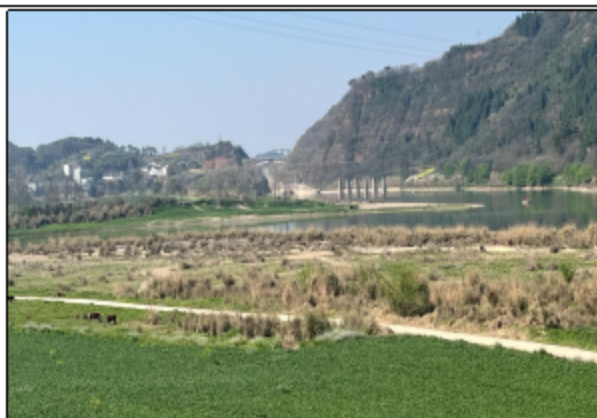
水厂取水口上游
