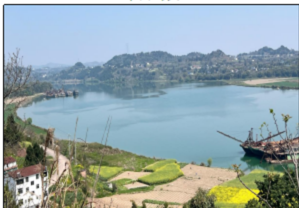
东西关电站坝址
