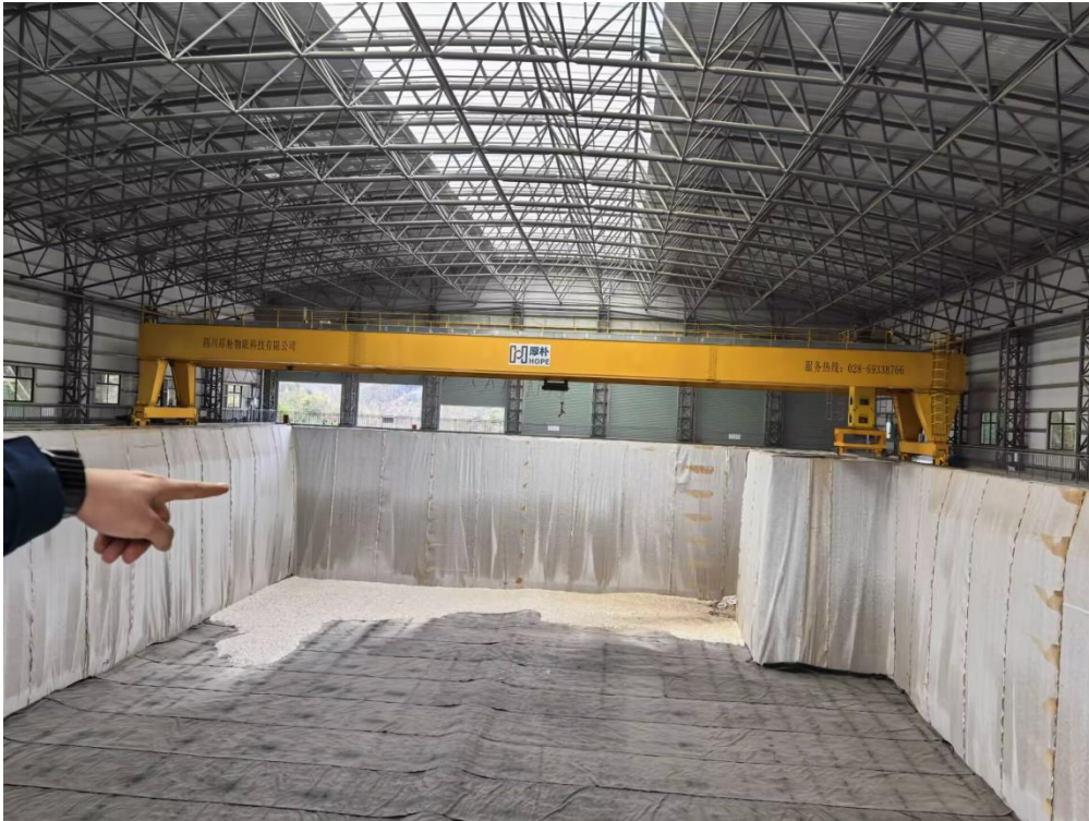
图 4.5-9 同类项目防雨棚内部照片
