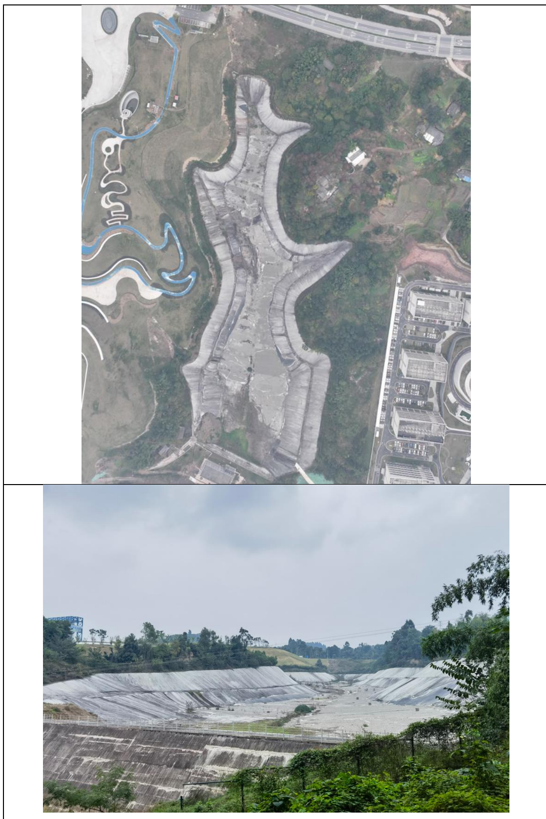
图 2.7-4 五通桥工业基地固体废弃物填埋场现状照片
