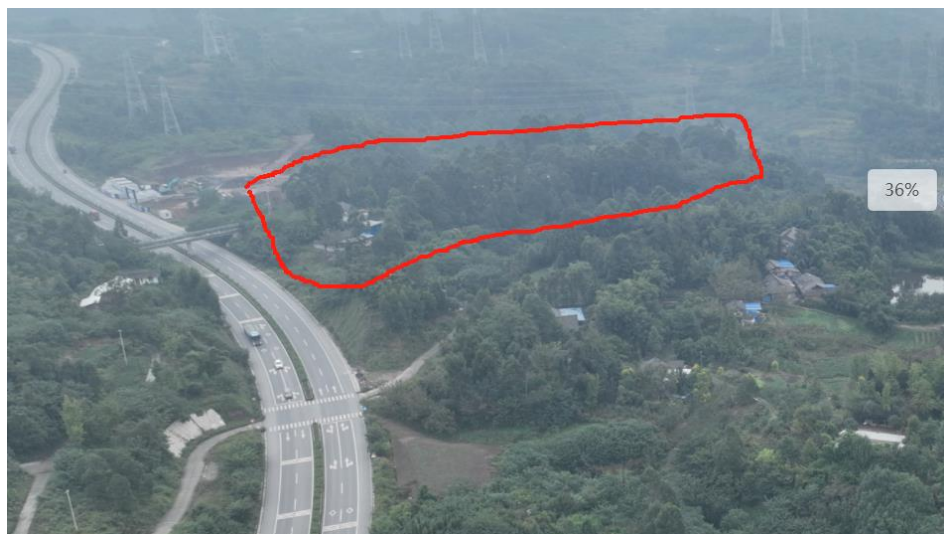
图 4.3-5 选址二现场照片
