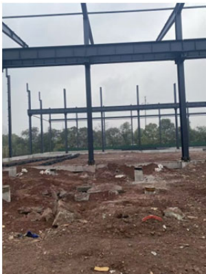
探伤室拟建位置
