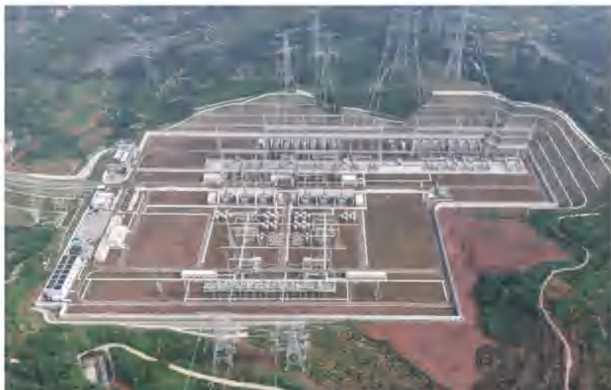
图 3.1-1 天府南（天府）变电站站址现状
