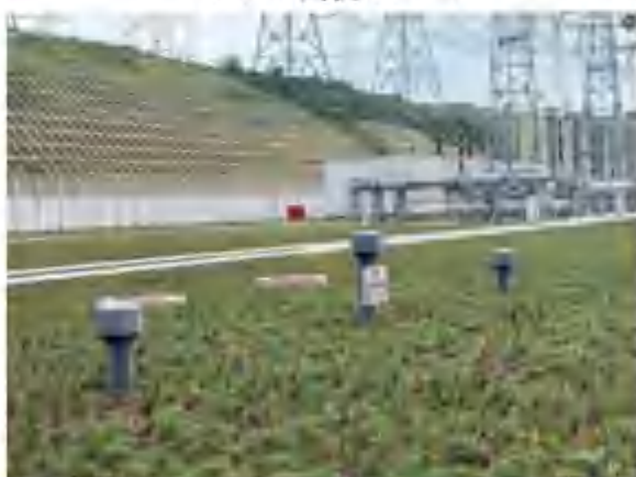
主变事故油池
