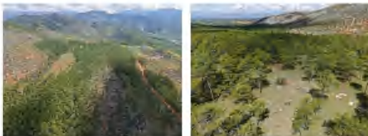
图 4.2-1 攀西 1000kV 变电站站址现状及周边地貌
