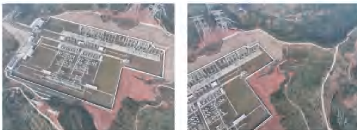
图 4.2-3 天府南（天府）1000kV 变电站站址现状及周边地貌
