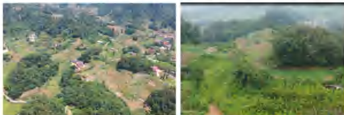
图 4.2-2 川南 1000kV 变电站站址现状及周边地貌
