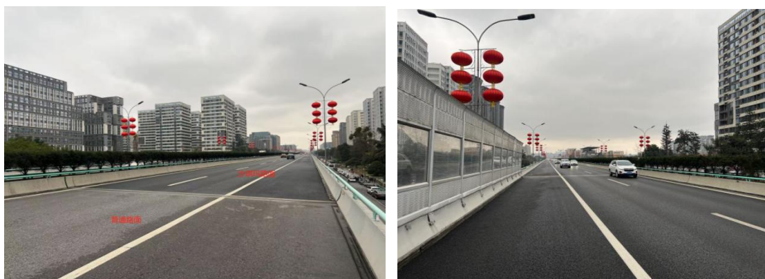
成都机场高速公路排水降噪路面（“沙琪玛路面”）
