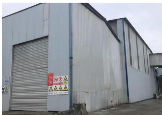
德阳市华益混凝土有限公司生产车间加装隔音棉并实行全封闭式生产
