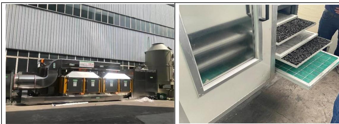
图 2-8 废气处理装置
