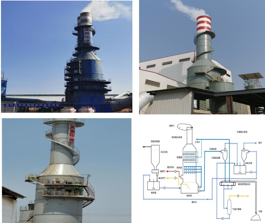
图 3-1-12 湿法脱硫工艺流程图与案例照片
