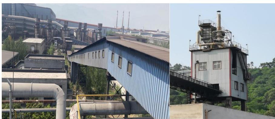
图 2-8 通廊封闭、转运站封闭
