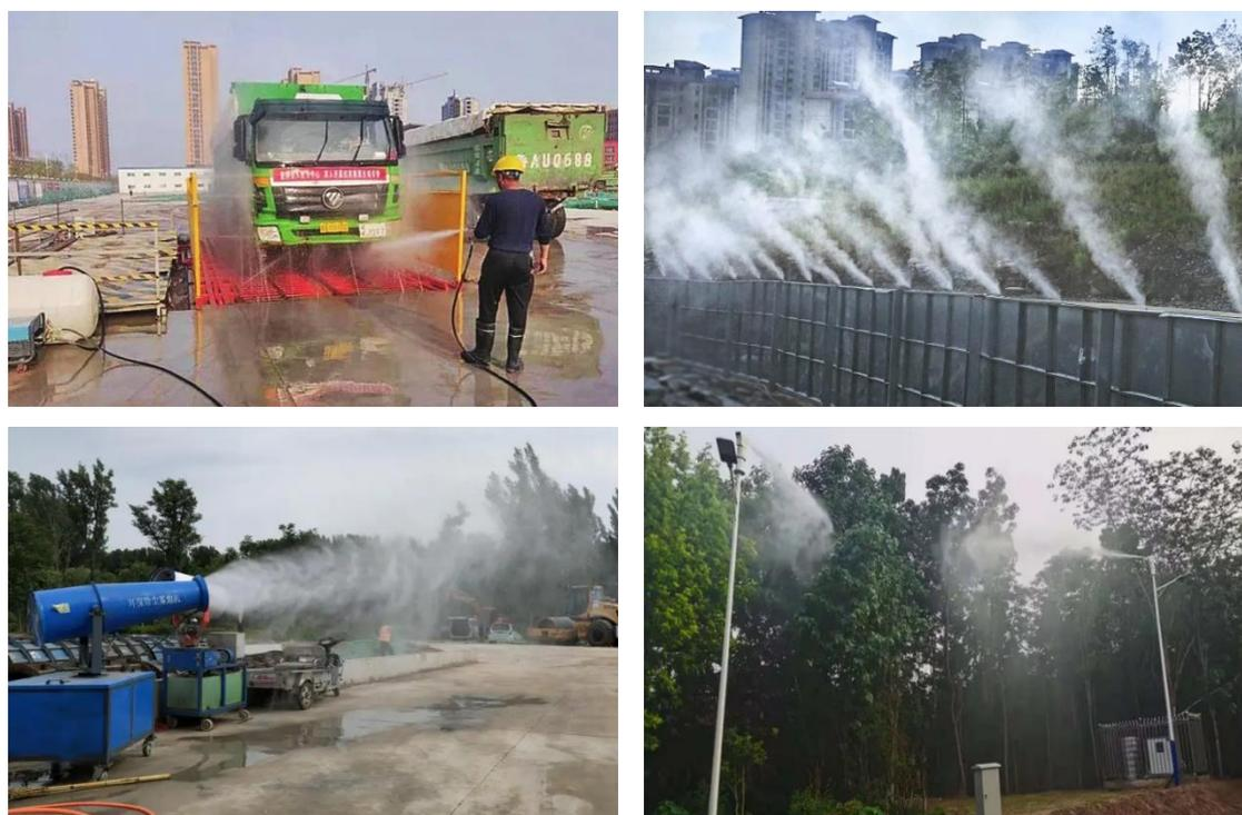
图 1-4 建筑施工扬尘抑尘措施
