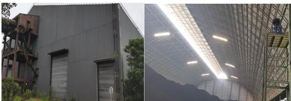
图 2-7 煤场封闭、棚内有雾炮等抑尘设施
